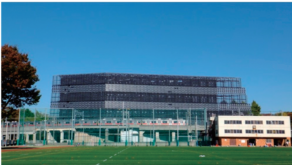
第42章 図13 東工大グリーンヒルズ棟の太陽電池 (本文 p. 123)
